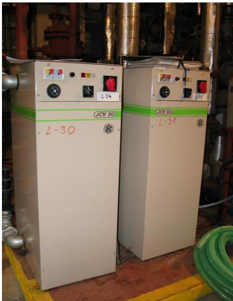
Obr. 20 Nově instalované elektrokotle
