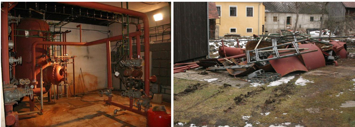
Obr. 29 Postupná demontáž akumulčních nádob a „zbytek“ původní kotelny
