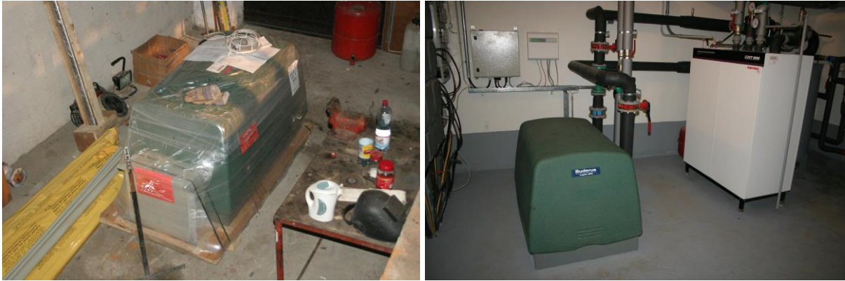
Obr. 25 Nové tepelné čerpadlo připravené k instalaci a dvojice tepelných čerpadel po rekonstrukci
