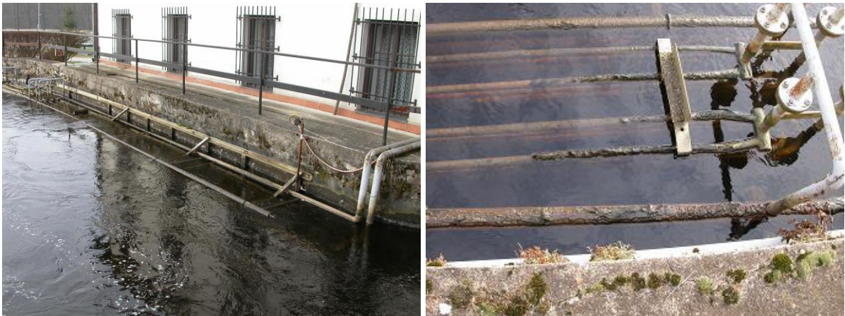
Obr. 26 Původní výměník primárního okruhu TČ v náhonu k vodní elektrárně
