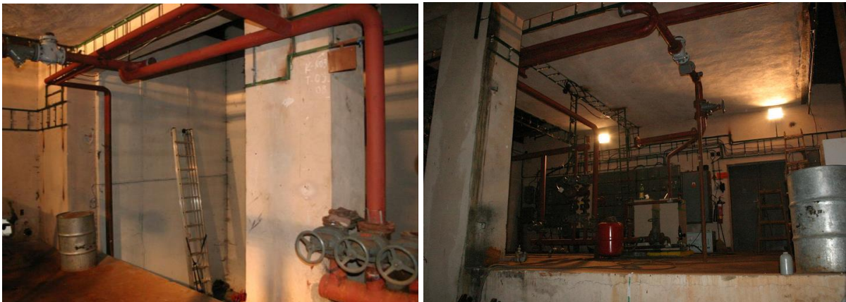
Obr. 28 Demontáž původního rozdělovače-sběrače
