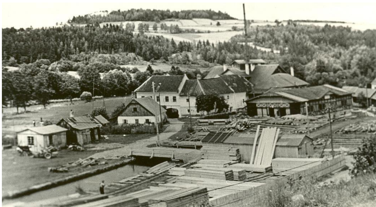
Obr. 1 Nejstarší dochovaný pohled na objekty bývalého vodního mlýna
