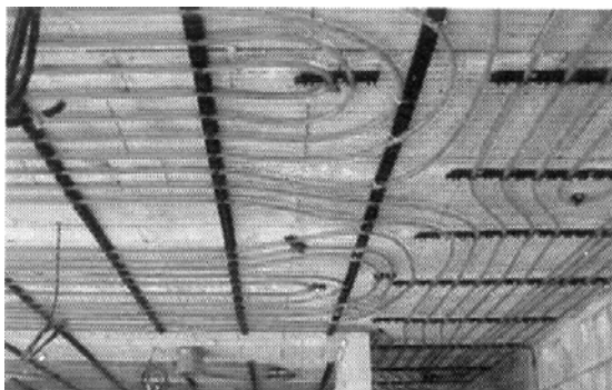
Obr. 78 Realizace mokrého způsobu stropního chlazení
