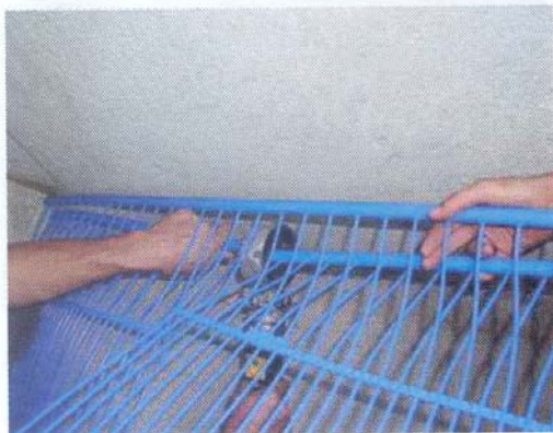
Obr. 25 Polyfúzní svařování sběrné a rozvodné trubky kapilárních rohoží
